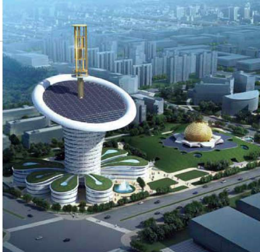
“武汉能源之花” 荷兰Grontmij集团(荷隆美)与Soeters Van Eldonk建筑事务所合作，在国际设计竞标中获胜，成为武汉新能源研究院的主设计方。该楼力争实现零碳排放，零能源供给，办公大楼高约140米，周围是叶片形的实验室环绕，此项设计可以让其在炎热的夏天置于其自身的荫蔽之下，而花瓣顶部主要由太阳能板组成用于提供能源。
